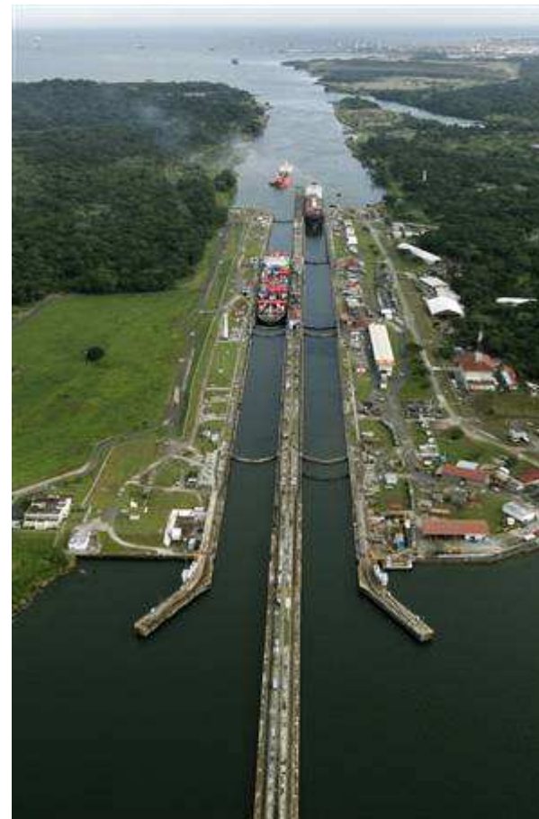
obr.4 Pohled na jednu z plavebních komor Panamského průplavu
